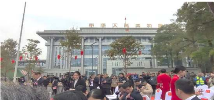
อาคารตรวจคนเข้าเมืองด่านหลงปัง
