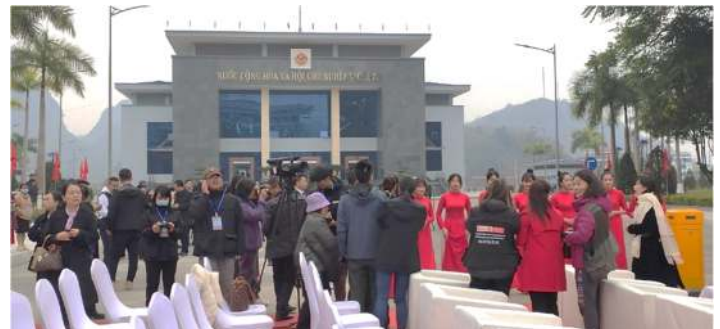
อาคารตรวจคนเข้าเมืองด่านจ่าหลินห์
