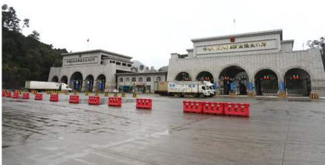
ด่านโหย่วอี้กวน มี 2 อาคาร แต่ละอาคาร มี 6 ช่องไม้กั้นรองรับการเข้า-ออกของรถบรรทุก 6 คัน (3 เข้า 3 ออก) โดยอาคาร 2 (ขวามือ) เป็นอาคารหลังใหม่ที่เปิดใช้งาน
