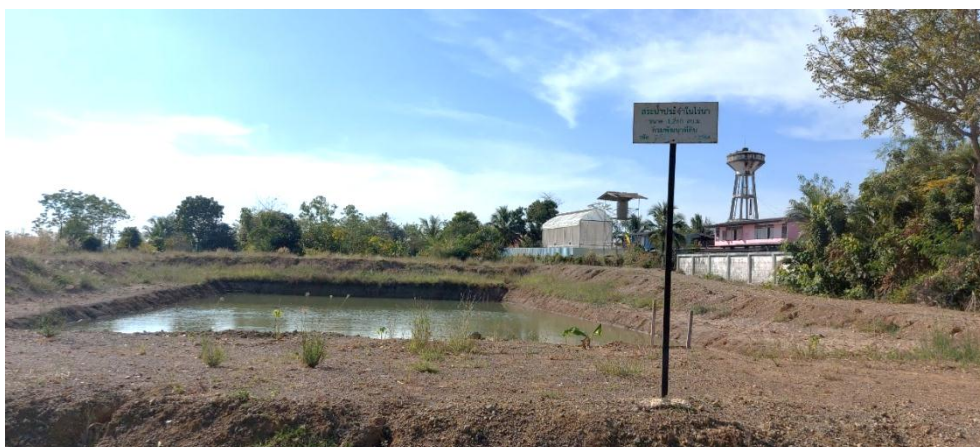
(โครงการก่อสร้างแหล่งน้ำในไร่นานอกเขตชลประทาน ของกรมพัฒนาที่ดิน จ.สระแก้ว)
