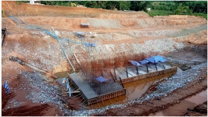
ภาพการก่อสร้างกำแพงกันดินเดือนสิงหาคม ๒๕๖๘
