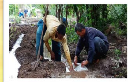
ดูแล ทางระบายน้ำ ให้พร้อม
