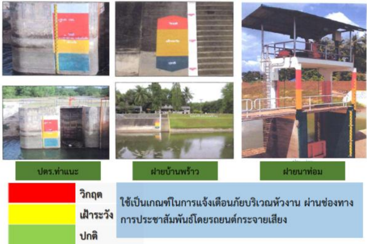
รูปที่ ๒๖ ระบบการแจ้งเตือนภัยโดยใช้ระดับน้ำหน้าอาคารชลประทาน
