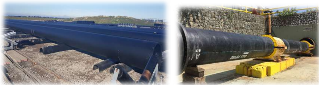
ภาพที่ 8.9 ท่อพีอีชนิดความหนาแน่นสูง (High Density Polyethylene, HDPE)
