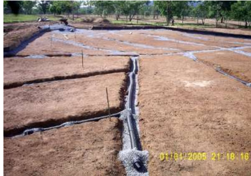
ภาพที่ 9.9 การวางท่อระบายน้ำบนกรีนสนามกอล์ฟ
