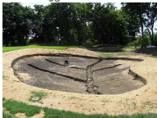
ภาพที่ 9.25 ระบบระบายน้ำแบบก้างปลา (Herringbone System)
