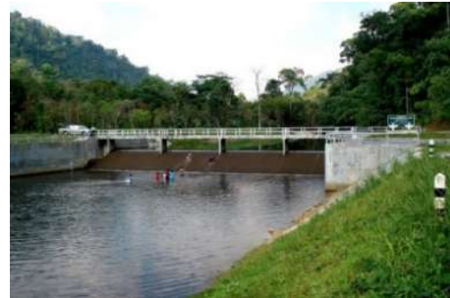
ภาพที่ 1.2 ฝายทอนน้ำคอนกรีต (ที่มา : โครงการชลประทานคลองลำภูใหญ่)
