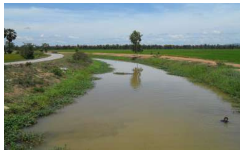
ภาพที่ 9.2 ปัญหาการรั่วซึมของน้ำชลประทานจากคลองขุดหรือคลองดิน (ที่มา : คลองชลประทานสายสาม อ.ท่ายาง จ.เพชรบุรี)
