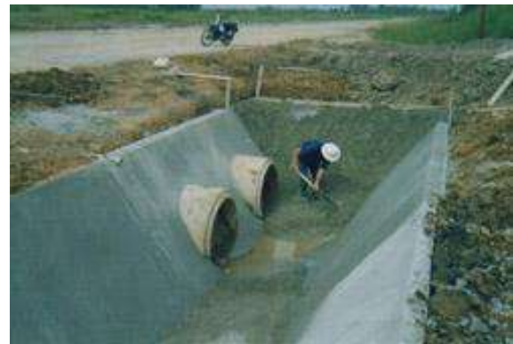
ภาพที่ 9.13 ลักษณะการระบายน้ำแบบลดระดับโดยใช้คูระบายน้ำ (ที่มา : กรมอาชีวศึกษา)
