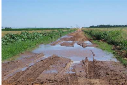
ภาพที่ 9.1 ปัญหาการระบายน้ำจากน้ำฝนและน้ำชลประทาน
