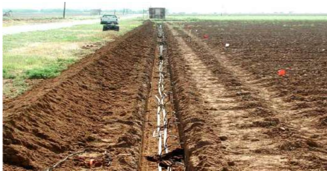
ภาพที่ 5.6 การวางท่อรองประธานเพื่อให้น้ำทางใต้ผิวดิน (ที่มา : sswm.info )
