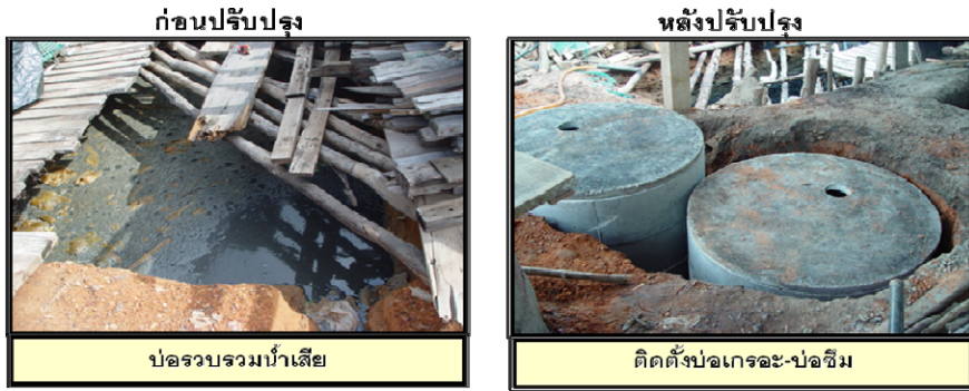
การติดตั้งบ่อเกรอะ-บ่อซึมเพื่อบำบัดน้ำเสียบ่อรวบรวมน้ำเสียแบบเปิด
