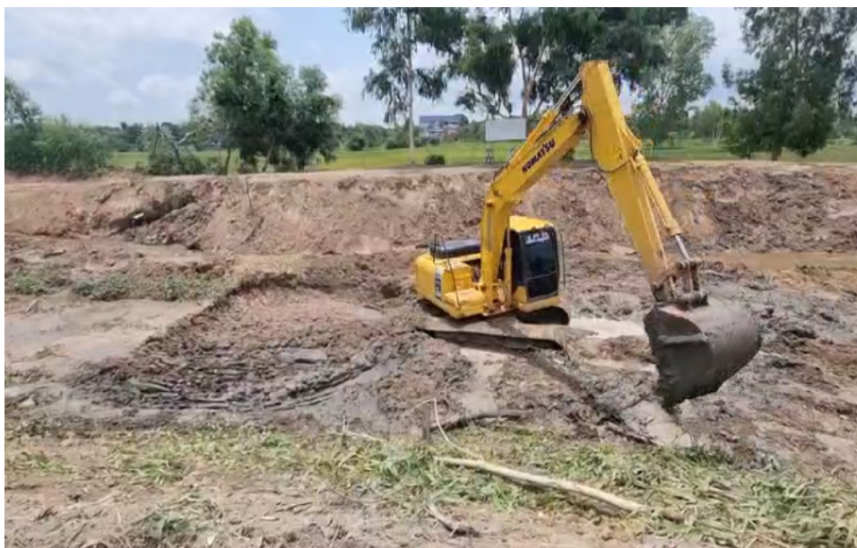
ภาพที่ 4-2 ขั้นตอนการดำเนินงานปรับพื้นที่บริเวณที่จะสร้างฝาย
