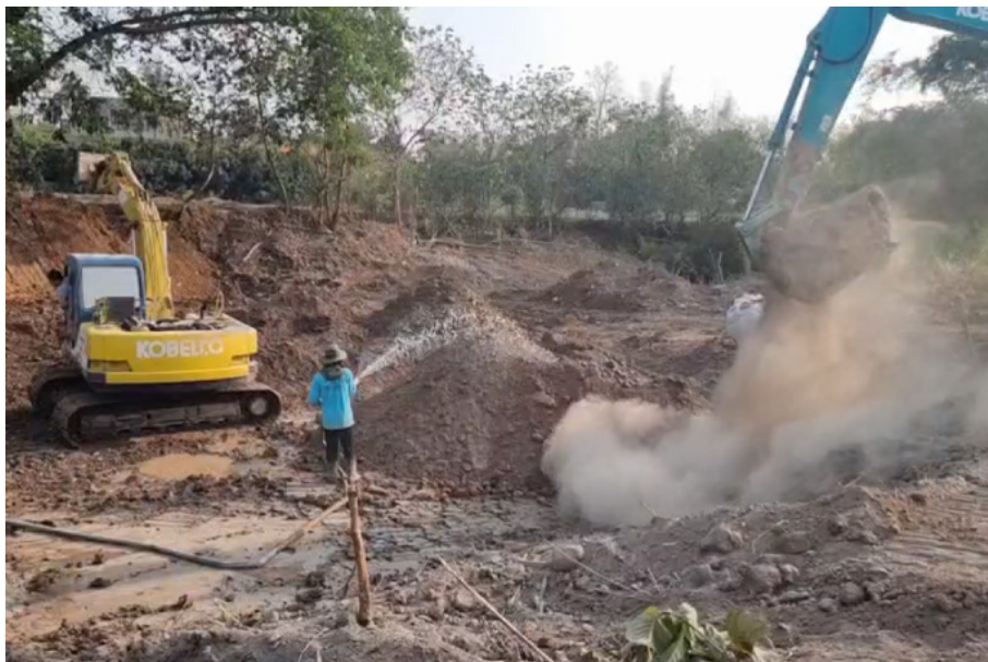
ภาพที่ 4-4 ขั้นตอนการดำเนินการผสมดินและซีเมนต์
