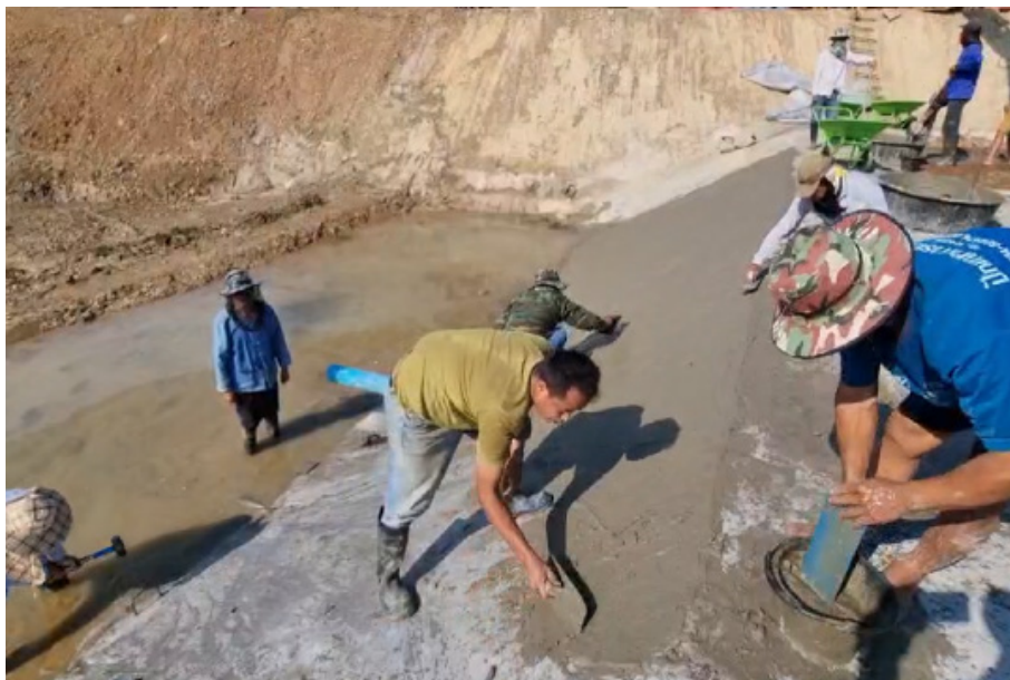
ภาพที่ 4-9 ขั้นตอนการเทพูนมอร์ตาร์เคลือบแผ่นใยสังเคราะห์
