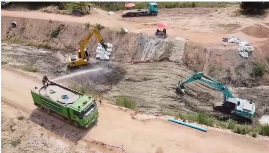
ภาพที่ 4-6 ขั้นตอนการดำเนินการบดอัดสันฝายและการวางท่อระบายน้ำพร้อมคอร์ล่า
