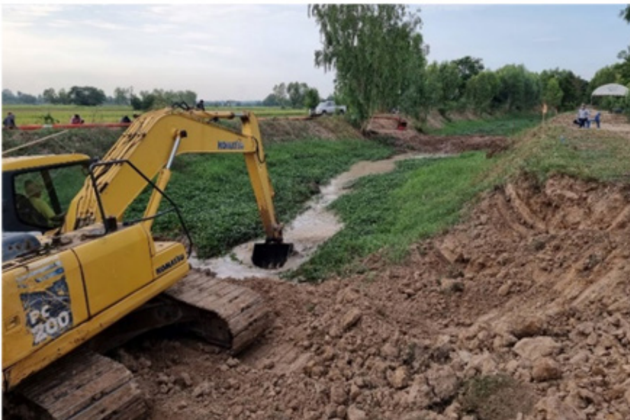
ภาพที่ 4-1 ขั้นตอนการดำเนินงานสร้างทำนบดินและสร้างทางระบายน้ำชั่วคราว
