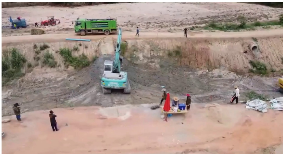
ภาพที่ 4-5 การบดอัดดินซีเมนต์พื้น และตัวฝาย
