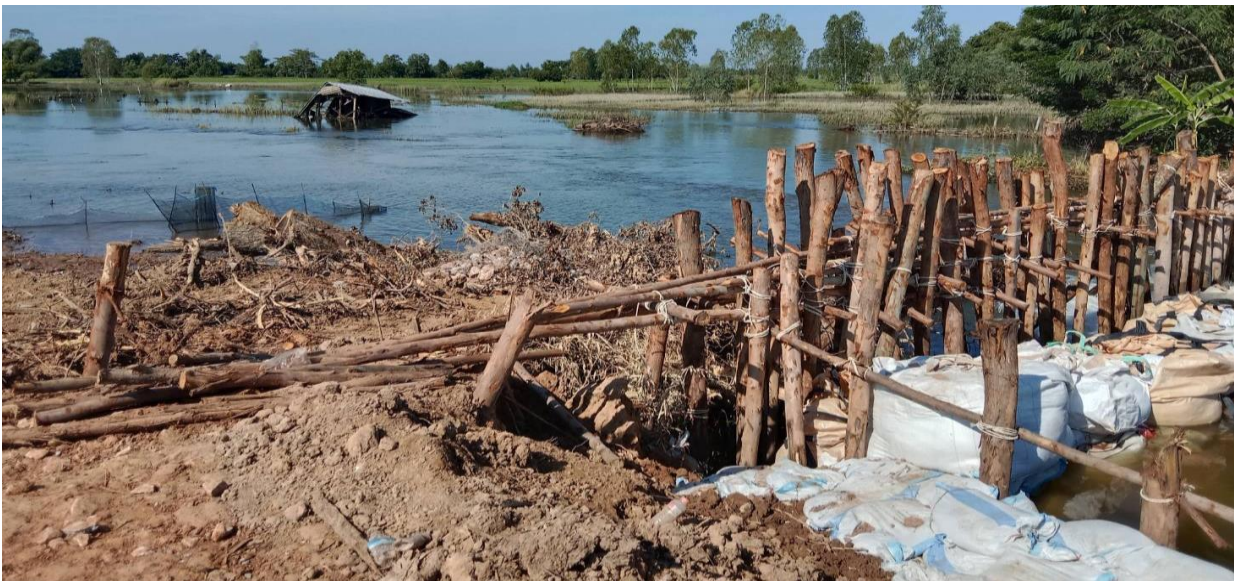
รูปที่ 14 ภาพพ้องกันน้ำหลังจากการซ่อมแซม
