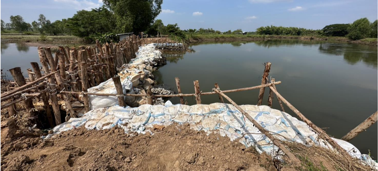
รูปที่ 13 ภาพพ้องกันน้ำหลังจากการซ่อมแซม
