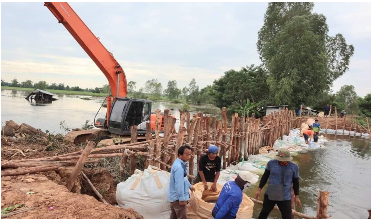
รูปที่ 10 ภาพส่วนราชการร่วมบูรณาการซ่อมแซมพนังกั้นน้ำลำน้ำก่า
