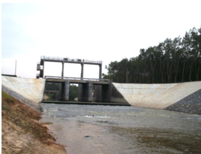
รูปที่ ๒.๒.๑-๕ ที่ตั้งโครงการประตูระบายน้ำคลองรัตภูมิ
