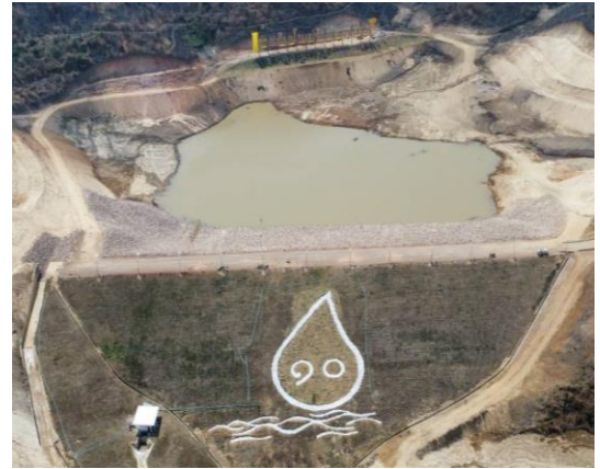
ทำตัวอักษรบริเวณลาดทำอ่างเก็บน้ำ แล้วเสร็จ
