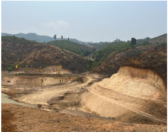
ตกแต่ง Slope ลาดไหล่เขาแล้วเสร็จ
