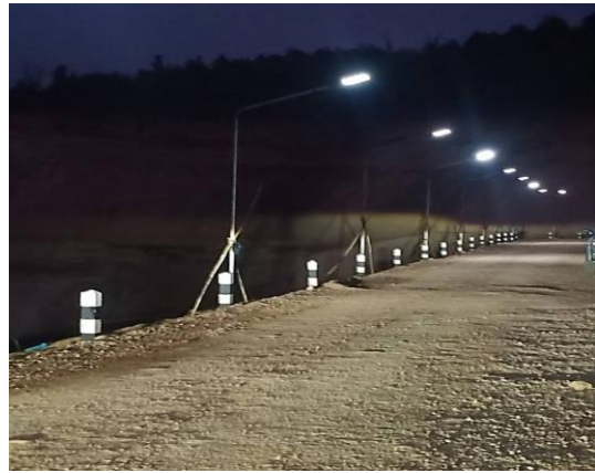
ติดตั้งเสาไฟฟ้าบนสันทำนบอ่าง แล้วเสร็จ
