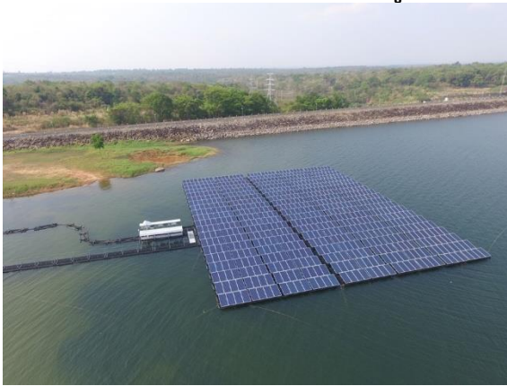
โรงไฟฟ้าพลังงานแสงอาทิตย์ทุ่นลอยน้ำ เขื่อนสิรินธร ตำบลช่องเม็ก อำเภอสิรินธร จังหวัดอุบลราชธานี
