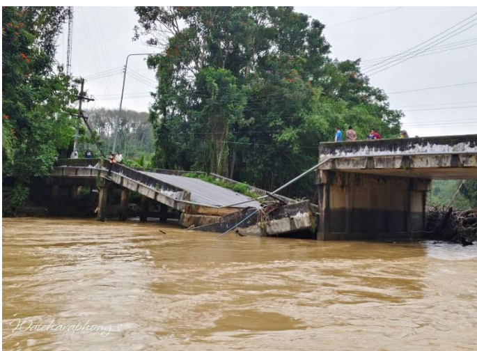
วันที่ ๑๒ พฤศจิกายน ๒๕๖๗ เกิดเหตุน้ำไหลหลากกัดเซาะได้สะพานระหว่างหมู่ที่ ๔ และหมู่ที่ ๖ ตำบลยะรม อำเภอเบตง จังหวัดยะลา
